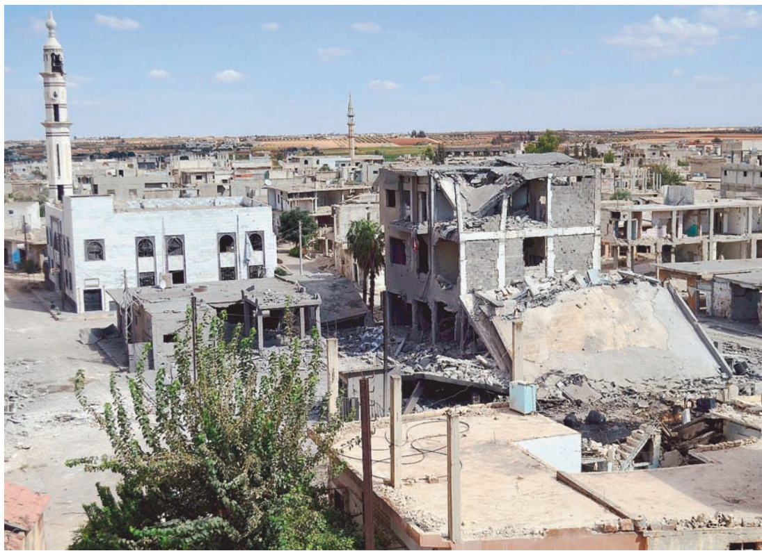
Ερημοί δρόμοι και κατεστραμμένα κτίρια στη συριακή πόλη Ταλμπίσεχ, της κεντρικής επαρχίας Χομς, ύστερα από τους βομβαρδισμούς που πραγματοποίησε χθες η ρωσική πολεμική αεροπορία.
