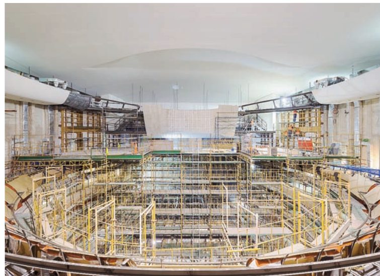
Η Κεντρική Σκηνή στο Κέντρο Πολιτισμού Νιάρχος υπό κατασκευή. Οι νέες εγκαταστάσεις προβλέπεται να παραδοθούν το πρώτο εξάμηνο του 2016.
